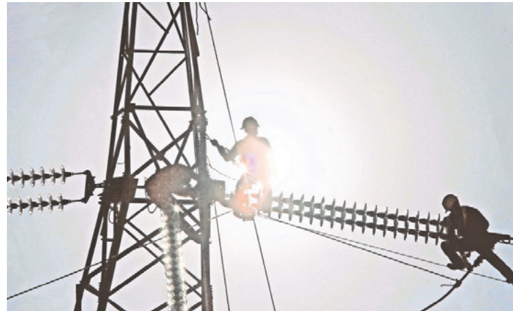
Históricamente, las inversiones para la infraestructura de distribución han sido mínimas, advierten expertos del sector energético.
