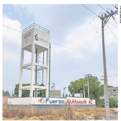
Fuerza Xiuhtecuitli apoyó a habitantes en la operación del pozo.
