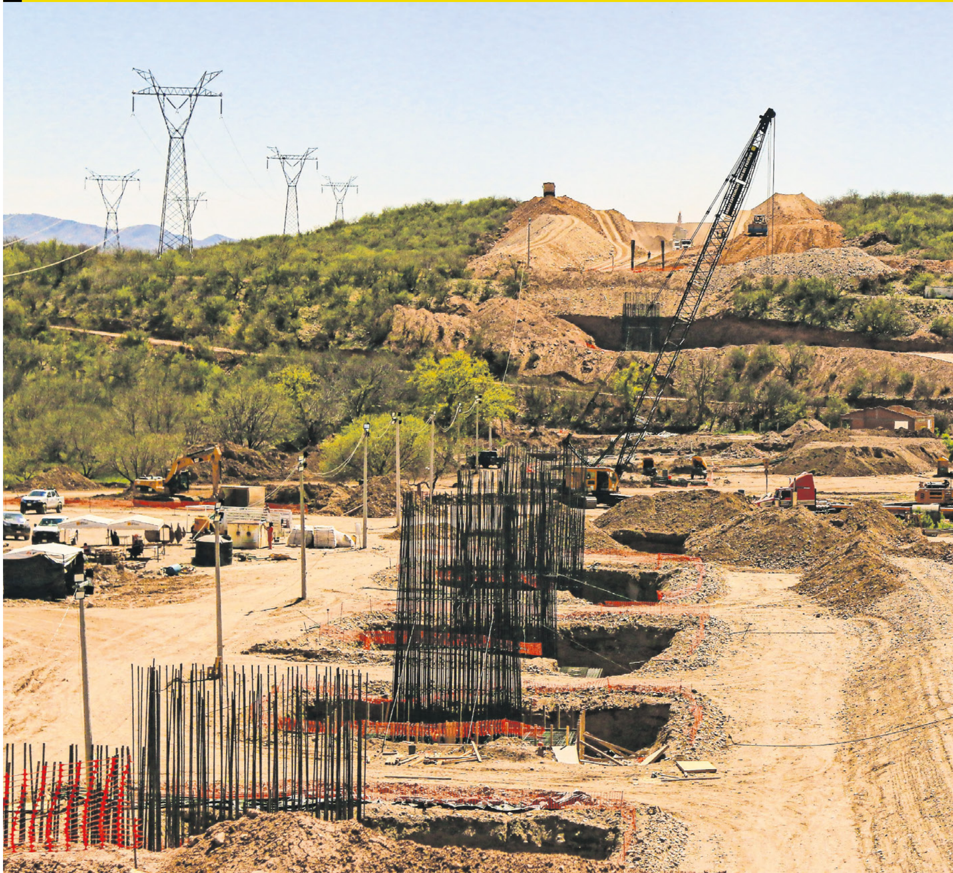
Este es uno de los trabajos que se realizan en Cocospera, Sonora, como parte de la reubicación de las vías del ferrocarril para librar la ciudad de Nogales.
