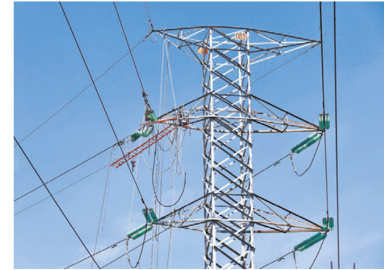
En marzo de 2024, sólo 4.6% de la energía fue generada en plantas hidroeléctricas en México, tecnología considerada como renovable.
